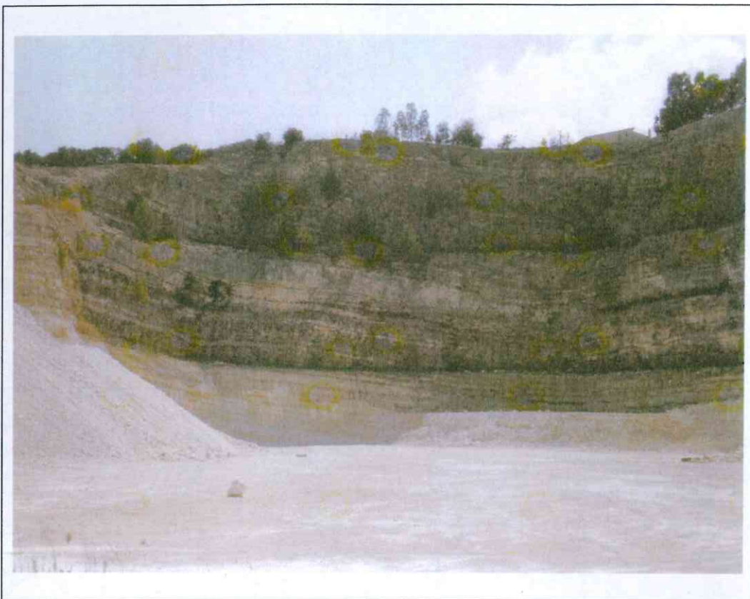
Foto 5 – Parte S caratterizzato da tre gradoni, con fronti alti dall'alto verso il basso 15, 12, e 7 metri. Calcare a stratificazione suborizzontale e parte superiore molto fratturata
