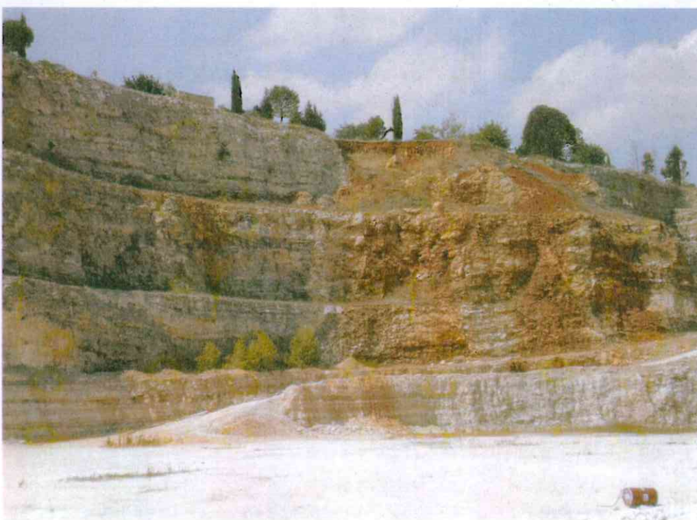
Foto 2 – Parte NO caratterizzato da quattro gradoni, con fronti alti dall'alto verso il basso 15, 12, 7 e 5 metri. Calcare a stratificazione suborizzontale con copertura di terra rossa
