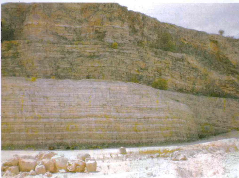
Foto 4 – Parte OSO caratterizzato da tre gradoni, con fronti alti dall'alto verso il basso 15, 12, e 17 metri. Calcare a stratificazione suborizzontale e parte superiore molto fratturata
